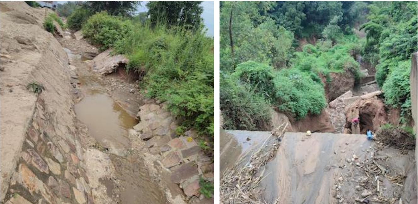
Dans sa partie amont qui traverse le quartier Rweza, les berges ne sont pas protégées et on observe beaucoup de glissements. Ces derniers sont renforcés par des constructions anarchiques intenses et des caniveaux qui se déversent dans la rivière, fragilisant les berges et provoquant un ravinement intense. Les maisons construites le long de la rivière et le long des caniveaux qui s'y déversent sont les plus en danger.
